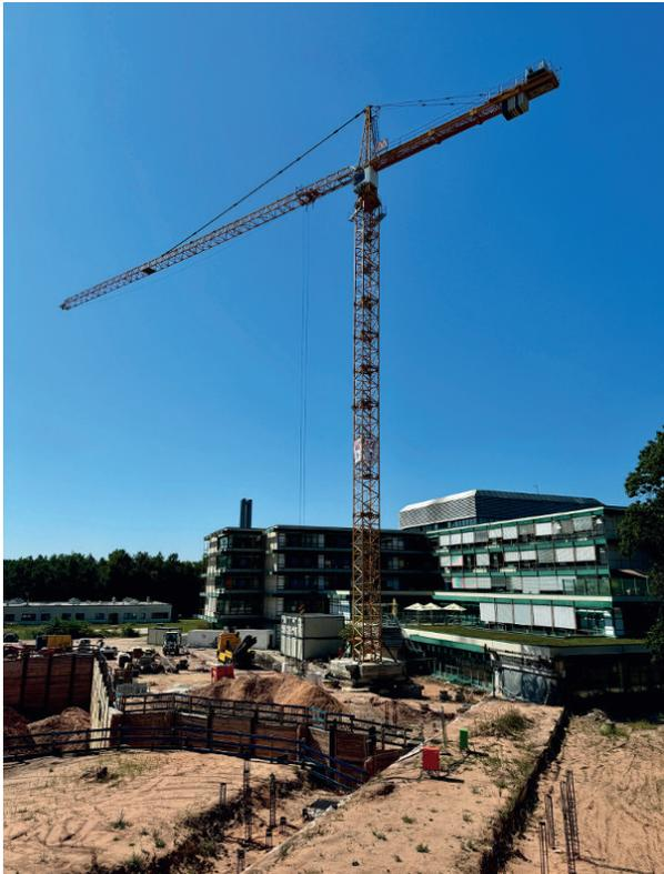
Einzel- sowie Streifenfundamente hergestellt. Nach Rückverfüllung können die Grundleitungen verlegt und die Bodenplatten hergestellt werden. Aufgrund der Größe muss die Herstellung der Bodenplatte in mehreren Abschnitten erfolgen. Anschließend können die aufgehenden Bauteile sowie die darüber liegenden Decken bewehrt, geschalt und betoniert werden. Für den Rohbau verantwortlich zeichnet die Firma Mauss Bau aus Erlangen.
